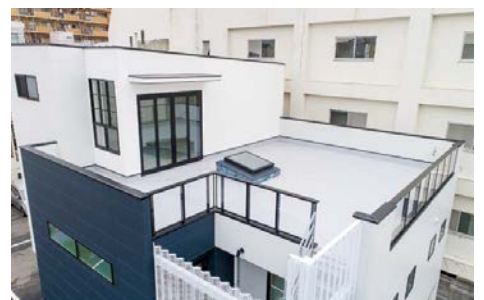
3階の屋上テラスは、災害時に避難場所としても機能する。
